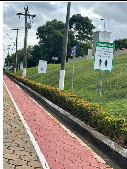
Foto 22: Passarelas para pedestres na propriedade 1
