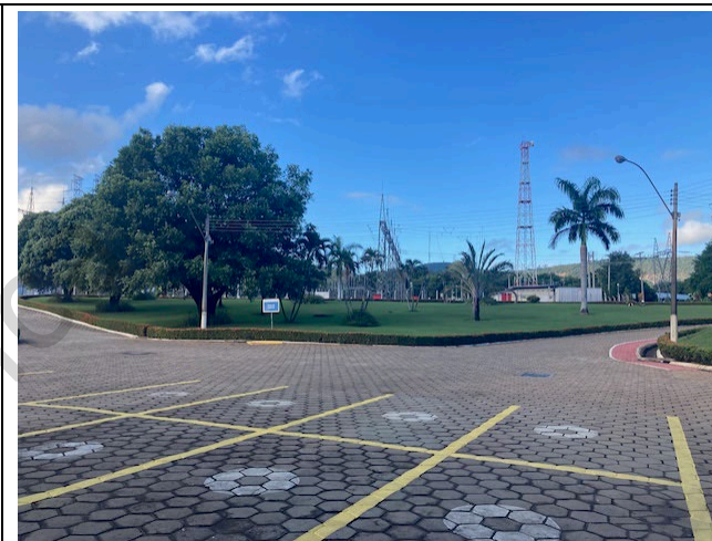
Foto 21: Paisagismo e sinalização entre a casa de força e a subestação
