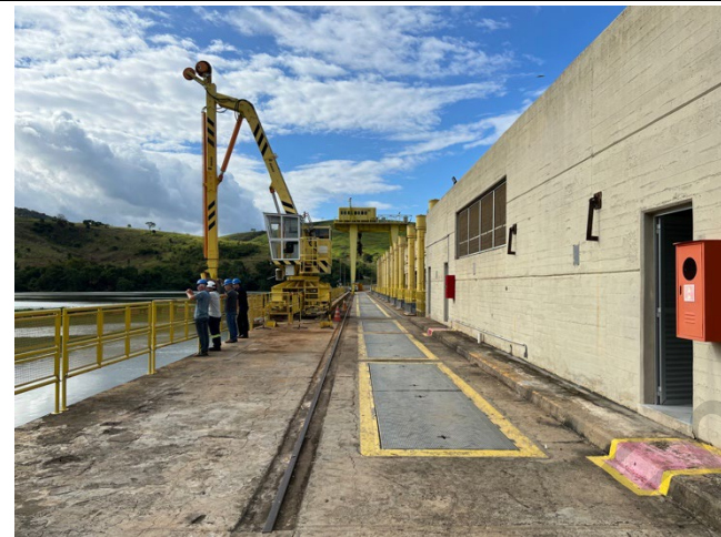
Foto 28: Equipamento de limpeza de grade de lixo a montante
