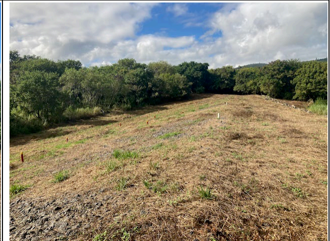
Foto 12: Barragem de sela / dique 2
