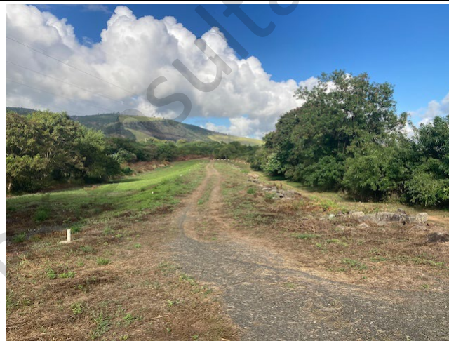
Foto 11: Barragem de sela / dique 1
