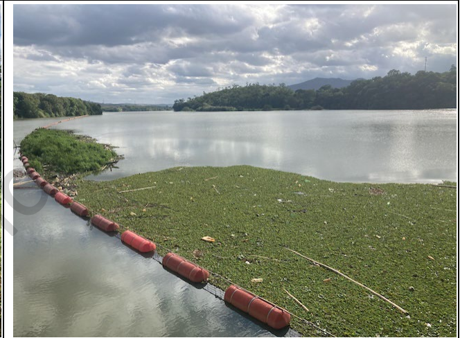
Foto 9: Log Boom de toras acima das tomadas de água com menor acúmulo de macrófitas
