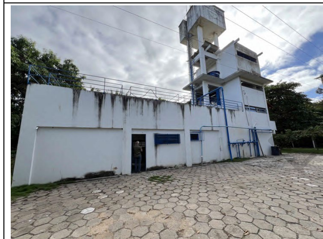
Foto 16: Estação de tratamento de água original para o projeto e agora operada pelo município
