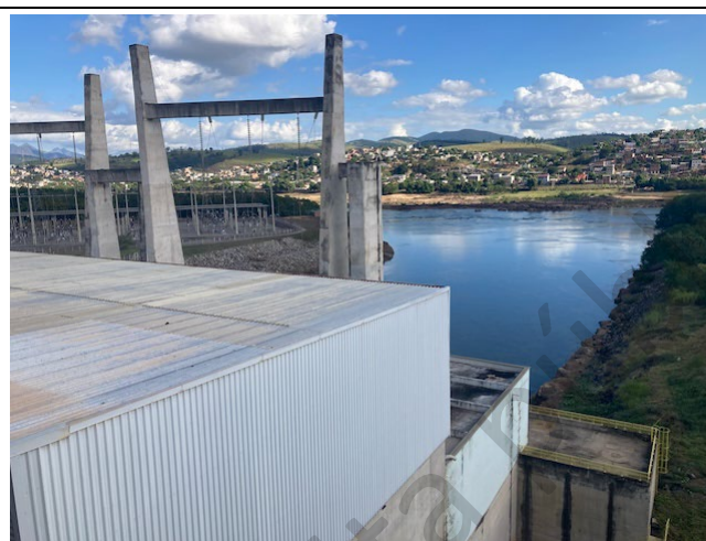
Foto 2: Vista da casa de força da UHE Aimorés (330 MW) para Rio Doce e cidade de Baixo Guandu
