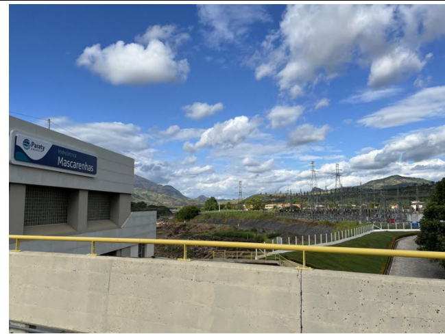
Foto 25: Linha de transmissão curta para a subestação
