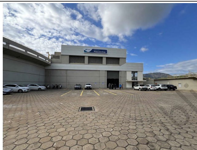
Foto 20: Entrada da casa de força
