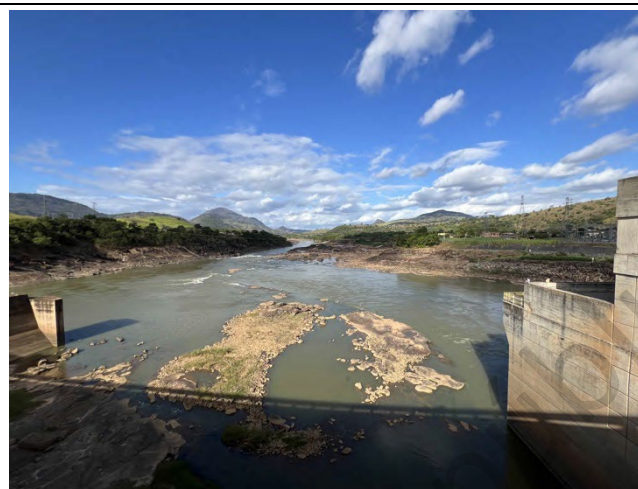
Foto 62: Vista da barragem central a jusante, casa de força à direita e vertedouro à esquerda
