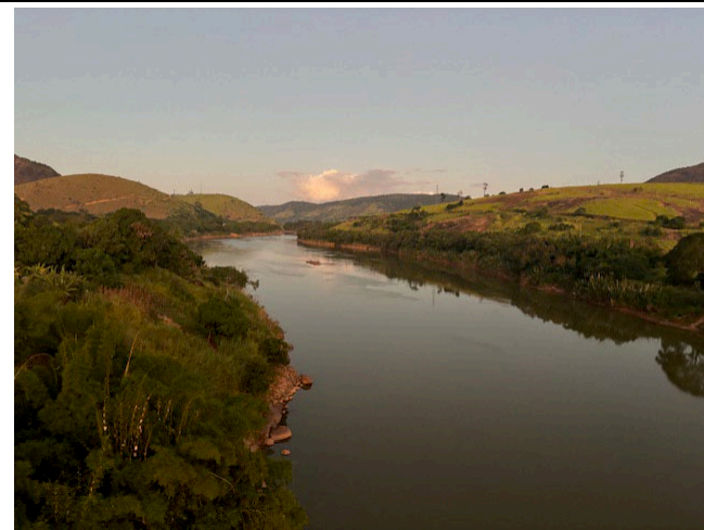
Foto 73: Vista a jusante da ponte da BR 259
