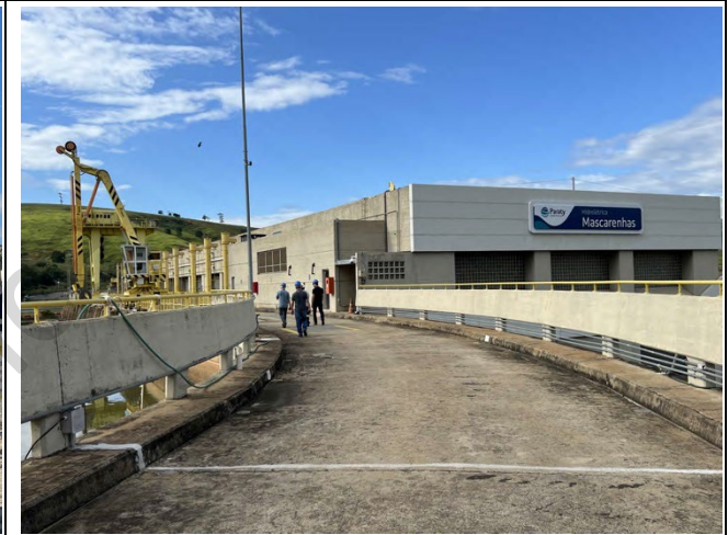
Foto 27: Estrada no topo da barragem de concreto
