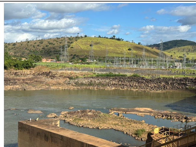
Foto 67: Subestação com vista da Vila Mascarenhas atrás
