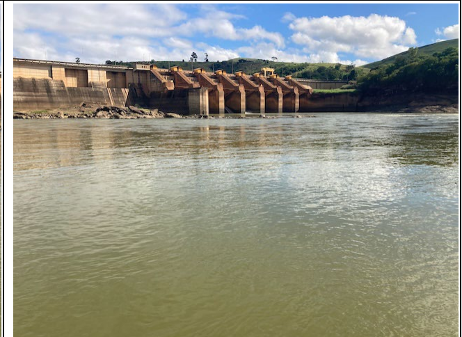
Foto 30: Vertedouro a jusante
