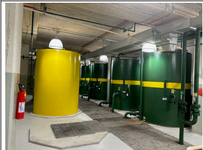
Foto 52: Separadores de óleo e água no andar mais baixo da casa de força
